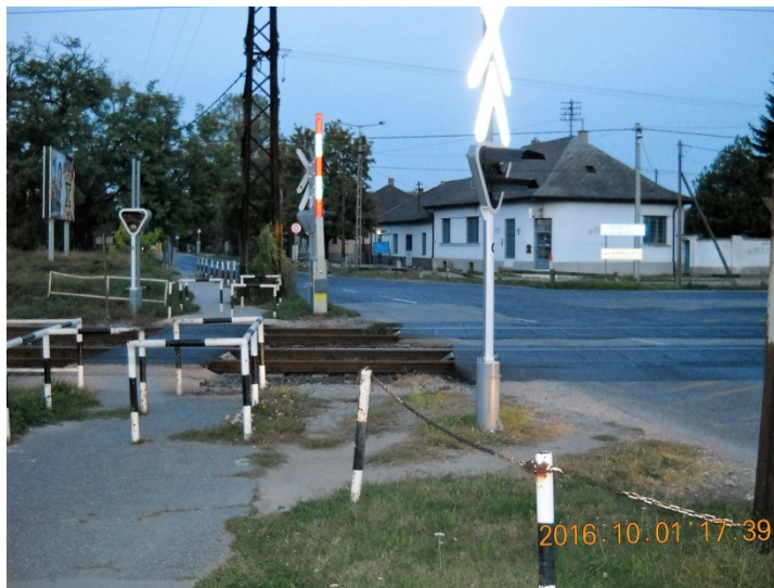
8. kép: A Batthyány utcai fény- és félsorompóval biztosított vasúti keresztezés (a Nagykanizsai vonalon), külön kerékpáros létesítmény nélkül
