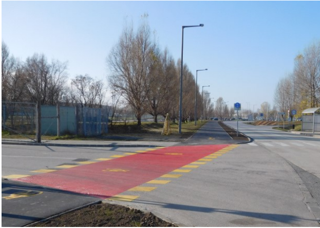
5. kép: A sóstó Ipari Parkban a Holland fasor melletti kerékpárút átvezetése az útcsatlakozásnál
