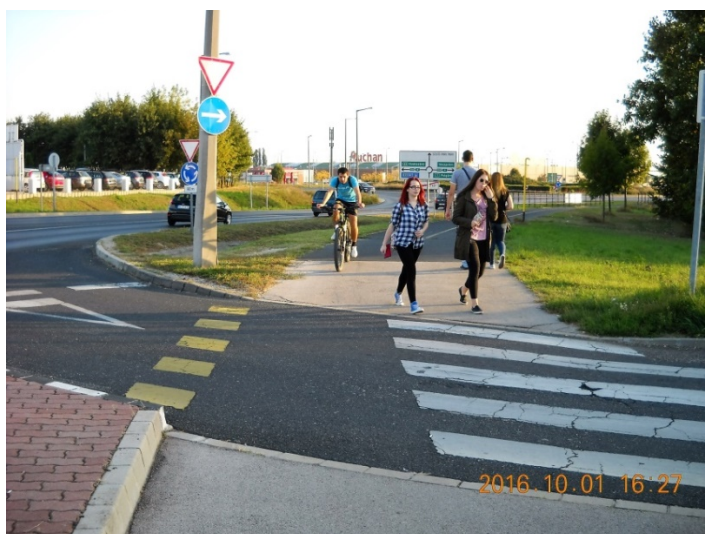
3. kép: A Sárkeresztúri út – Sóstó út útcsatlakozása a kerékpáros átvezetéssel
