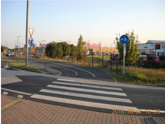
18. kép: 2. szakasz optikailag elválasztott gyalog-és kerékpárútja, a körforgalmak között, a 8.sz. főúti ágtól
